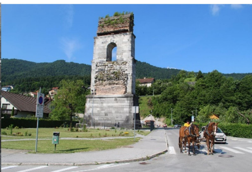
Slika 6: Ostanek Borovniškega viadukta
